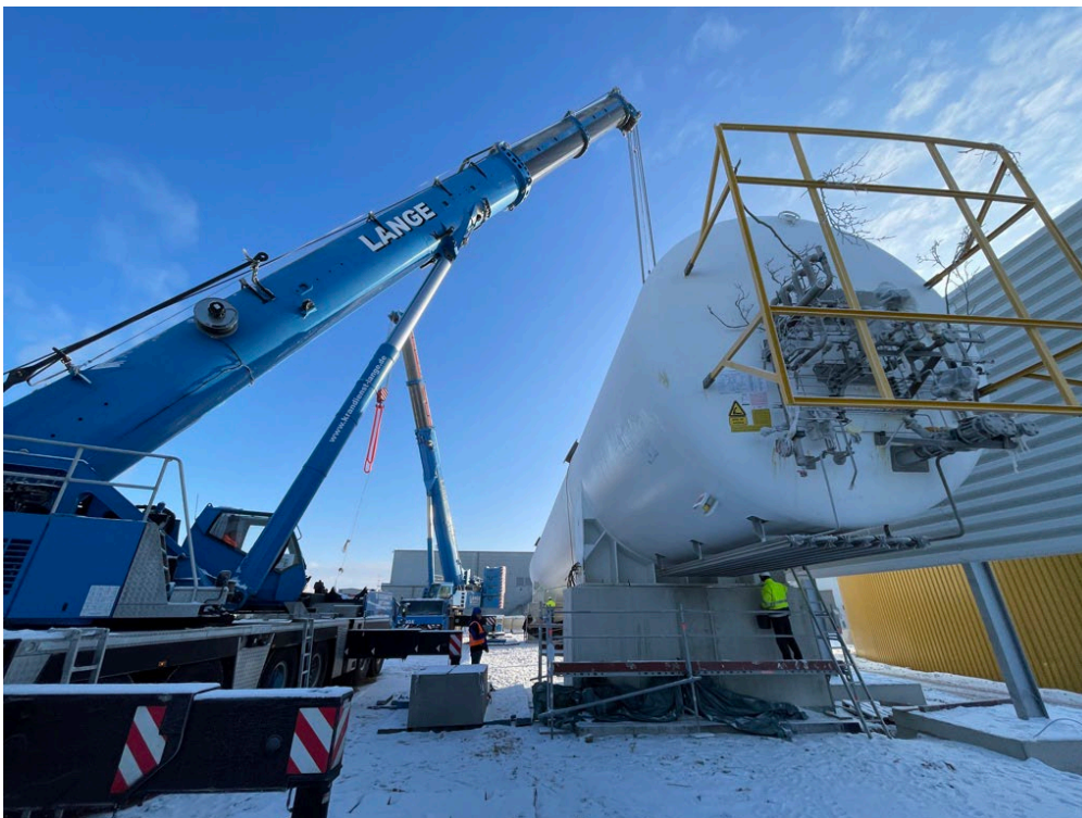
Zwei Schwerlastkräne haben den 130 Tonnen schweren Tank in Position gebracht (Foto: EnviTec Biogas AG)
