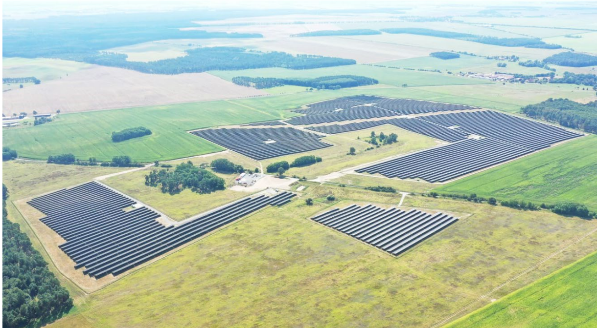
EnviTec Biogas liefert mit dem PV Park Buckow jährlich 65 MW an PowerCo SE (Foto: EnviTec Biogas AG)
