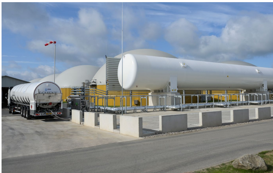
Bis zu 25.000 kg Bio-LNG pro Tag und 18.000 Tonnen LCO 2 pro Jahr werden hier aus überwiegend landwirtschaftlichen Reststoffen hergestellt. (EnviTec Biogas AG)
