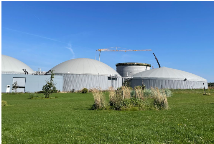
Die Industrieanlage mit angegliederter EnviThan-Biogasaufbereitung erzeugt über 800 Nm 3 /h hochreines Biomethan und speist dieses in das örtlich vorhandene Gasnetz ein. (EnviTec Biogas AG)
