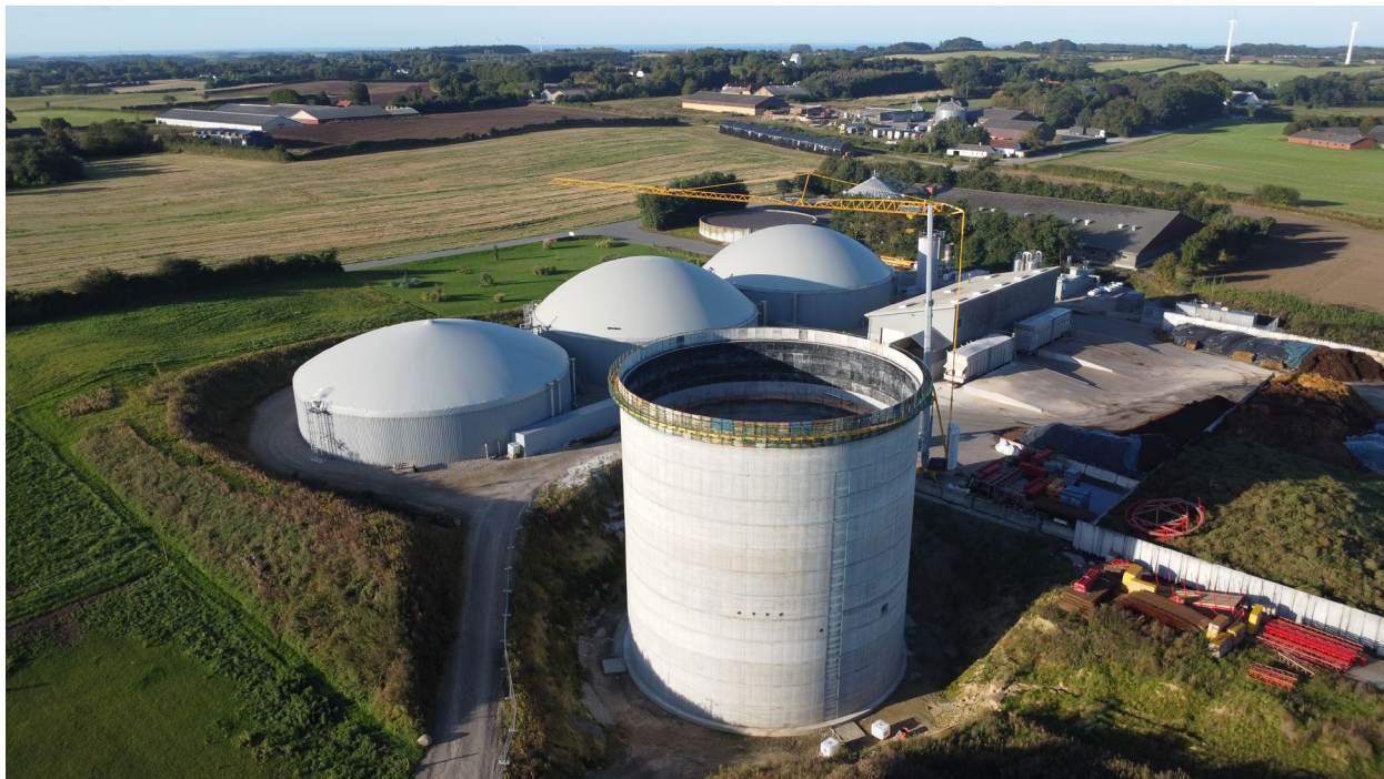
Der 25 Meter hohe Betonfermenter wurde sieben Meter tief in die Erde eingelassen. (EnviTec Biogas AG)
