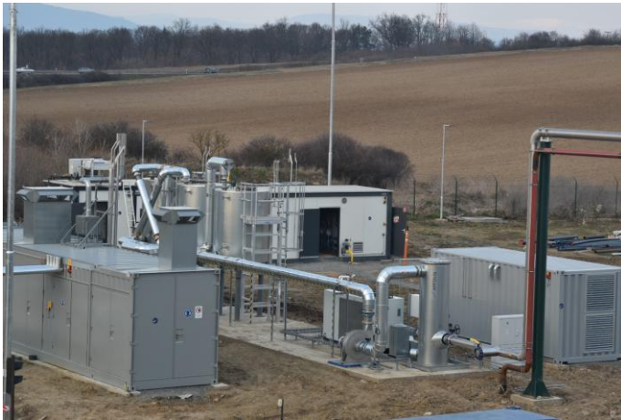
Die 417 Nm 3 /h EnviThan-Gasaufbereitungsanlage bildet das zweite Biomethanprojekt von EnviTec Biogas in der Slowakei. (Foto EnviTec Biogas AG)
